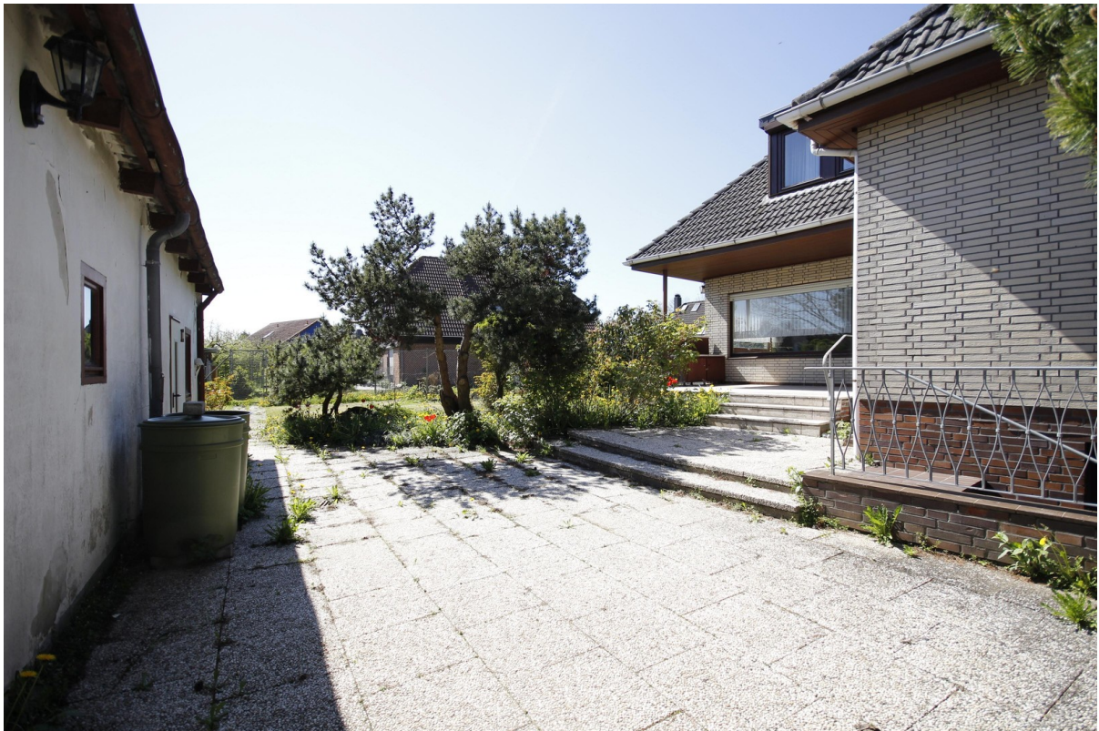
Übergang Garagen - Terrasse
